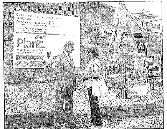
El subdelegado y la alcaldesa, en una de las obras
